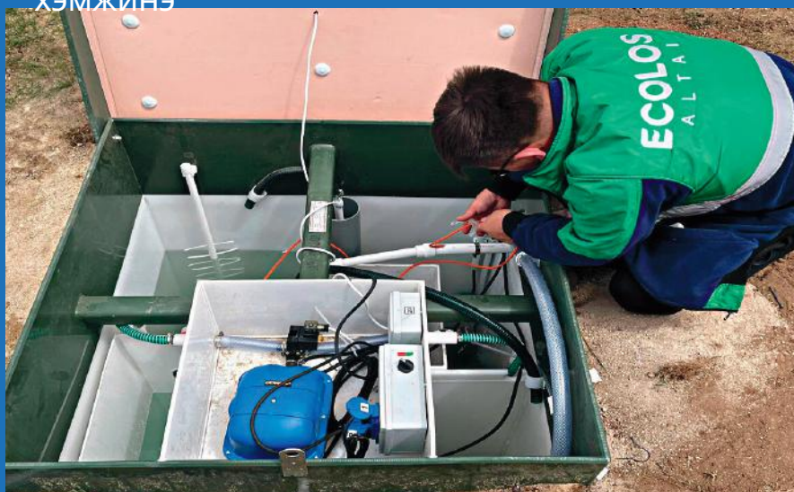
Элсээр булж ус дүүргэн шалгаж хүлээлгэж өгнө
